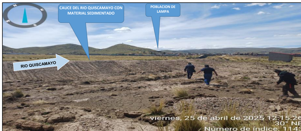
FIGURA 2: TRAMO CRÍTICO EN EL RÍO PUCAMAYO, NOTESE EL DESBORDE E INUNDACION A CAUSA DE LA SEDIMENTACION QUE REDUCE LA SECCION HIDRAULICA DE L CAUCE DEL RIO.
