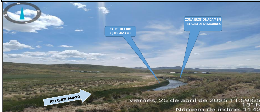
FIGURA 1 y 2 : TRAMO CRÍTICO EN EL RÍO QUISCAMAYO, LA ACUMULACION DE MATERIAL SEDIMENTADO EN EL CAUCE, QUE REQUIERE SER ELIMINADO PARA REESTABLECER LA SECCION HIDRAULICA DE LA CAJA DEL CAUCE EN ESTE SECTOR.
